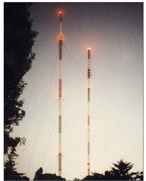
Die beiden selbststrahlenden Sendemasten der Sendeanlage Berlin-Britz: links der 144 m hohe Südostmast, rechts der 160 m hohe Nordwestmast. Foto: Lutz
