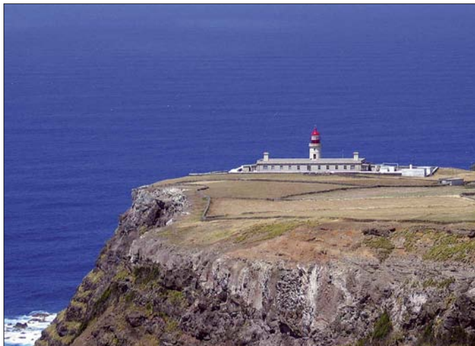
Der Leuchtturm Albarnaz mit seinem exponierten Standort auf den Klippen
